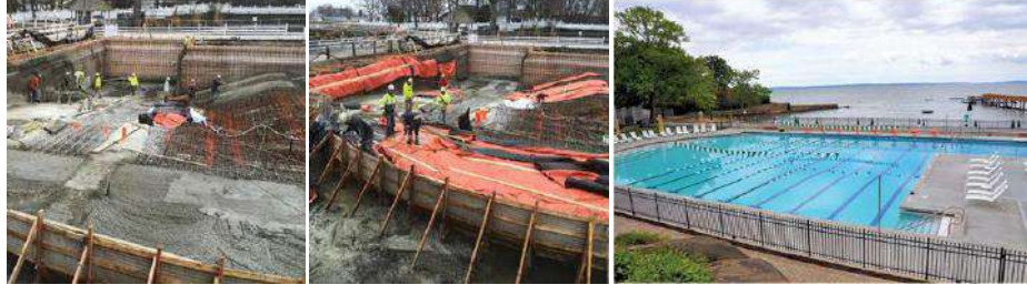
Şekil 12. Yüzme havuzuna püskürtme beton uygulama aşamaları (Guarino, 2017).
