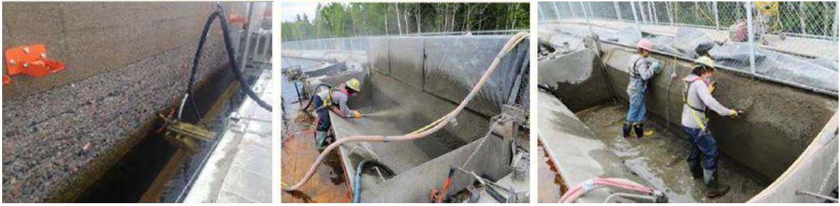
Şekil 7. Mobil çalışma alanında püskürtme beton uygulaması ve püskürtme beton uygulanmış yüzeye kesme, sonlandırma işlemi ve uygulama sonrası (Côté, vd., 2015).
