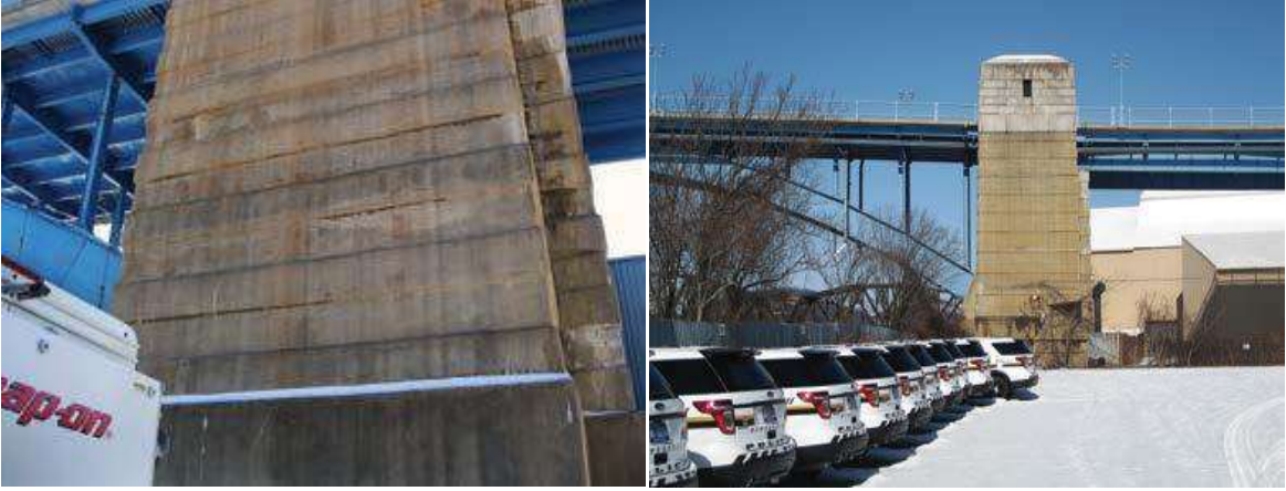
Şekil 9. 31. Cadde Köprüsü (Sofis, 2015).
