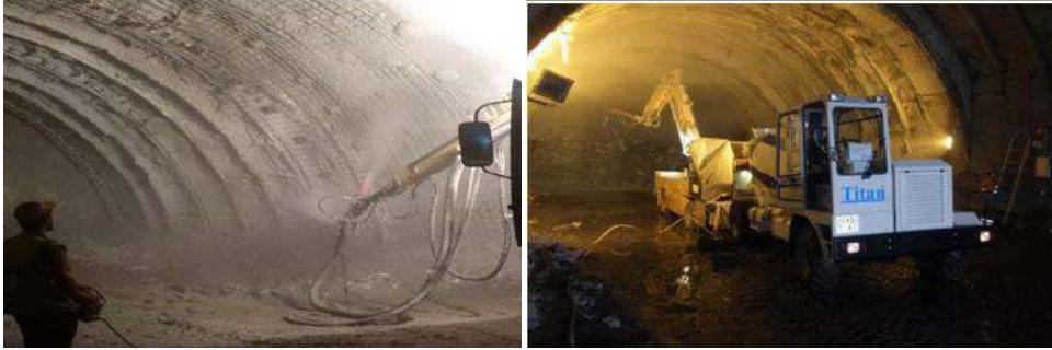
Şekil 3. Tünel içinde yaş karışım püskürtme beton uygulaması
