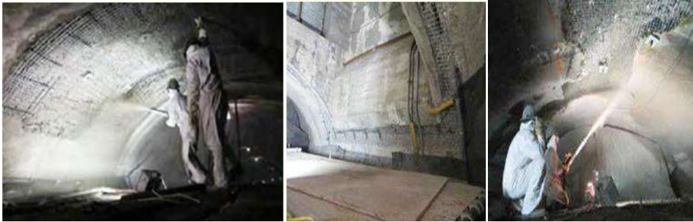
Şekil 4. Tünel yüzeyine kuru karışım püskürtme beton uygulaması (Robertson, vd., 2016)
