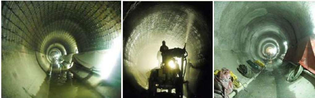
Şekil 2. Püskürtme beton öncesi yüzey hazırlığı ve donatı yerleştirilmesi, uygulanması ve bitmiş hali (Jimenez, 2017)
