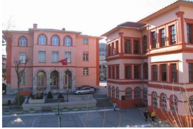
Şekil 11. İstanbul Vefa Anadolu Lisesi okul binasının güçlendirilme sonrası fotoğrafı (www.erolkara.net/2014).
