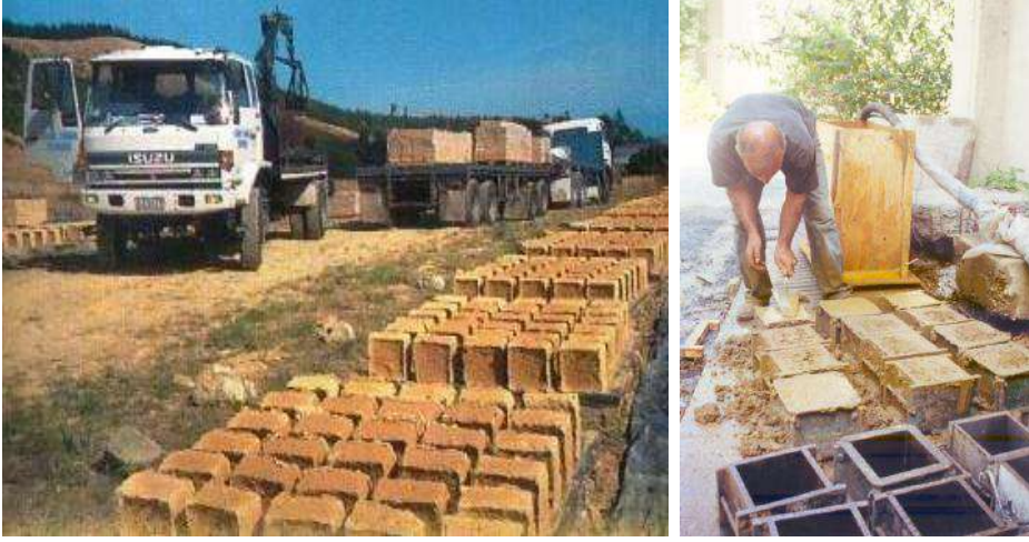
Şekil 4. Kerpiçin hazırlanması
