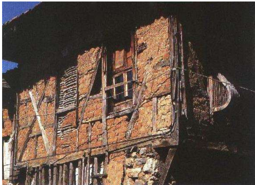
Şekil 3. Blok kerpiç dolgulu ev, Cumalıkızık, Bursa
