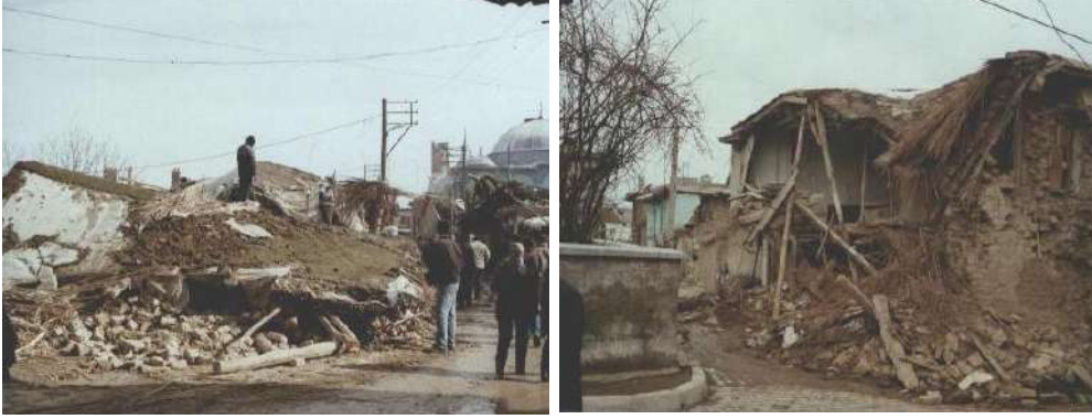
Şekil 5. Konya-Akşehir yöresi kerpiç malzemeli, ağır toprak damlı yapı
