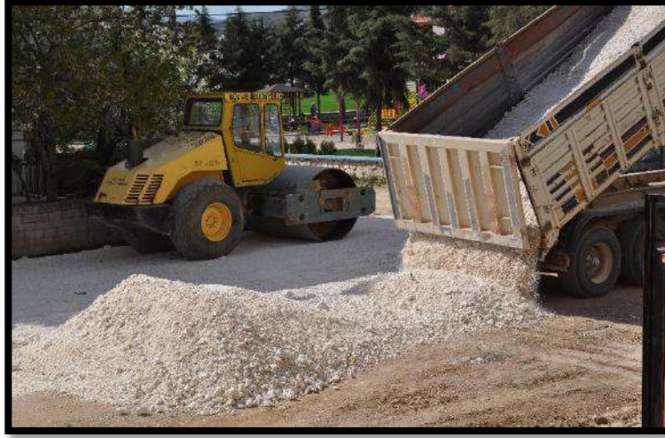
Şekil 5. Yol yapımında alt dolgu malzemesi olarak kullanılan mermer artıkları
